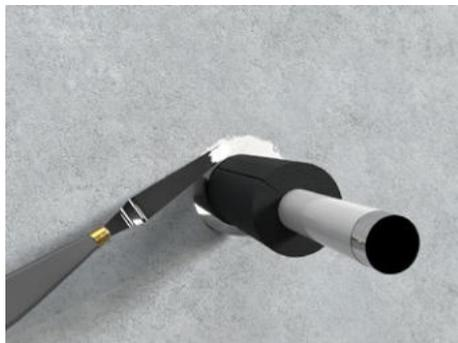
4. Jede Rohrabschottung ist mit einem Schild dauerhaft zu kennzeichnen. Das Schild ist jeweils neben der Rohrabschottung am Bauteil zu befestigen.
