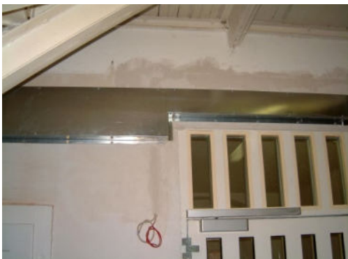
Foto: FKS-Kanal, 3-seitig, fester Deckel, Direktmontage auf Wand, Höhenversatz und 135° Ecke
