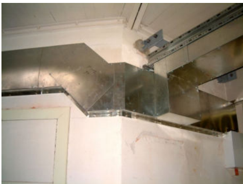
Foto: FKS-Kanal, 3-seitig, fester Deckel, Direktmontage auf Wand, Höhenversatz und 135° Ecke
