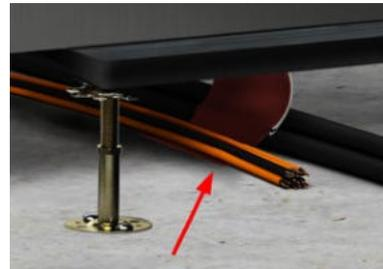
3. Cable Tube ML vorsichtig über die Leitungen klappen. Darauf achten, dass sich alle Leitungen vollständig innerhalb der Halbschale befinden.
