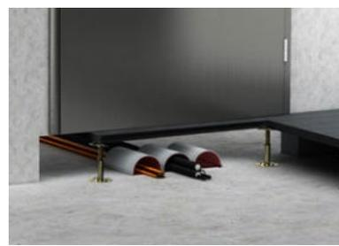
5. Schottmasse gemäß Verpackungsanweisungen anrühren und so einbringen, dass an den Seiten ein fester, dichter Anschluss zum Bauteil entsteht. Oben müssen ca. 2 cm zum Systemboden als Dehnfuge verbleiben.
