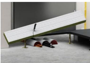
6. Kanten der Mineralfaserplatte mit FLAMMOTECT-A einstreichen und Platte stramm sitzend einbringen. Die Mineralfaserplatten so einbringen, dass die beschichteten Seiten nach außen zeigen.
