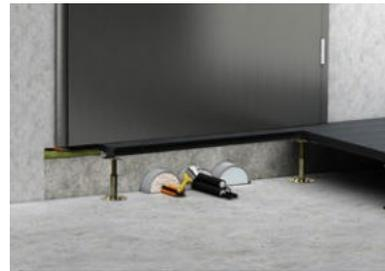
9. Schott kennzeichnen. Schottschild sauber ausfüllen und dauerhaft neben/über (nicht auf!) dem Schott anbringen
