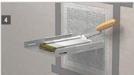
Nach dem Schließen der Bauteilöffnung sind alle Spalten und Fugen jeweils auf der äußeren Seite mit den Ablationsbeschichtungen BMS bzw. BMK flächeneben zu verspachteln.
